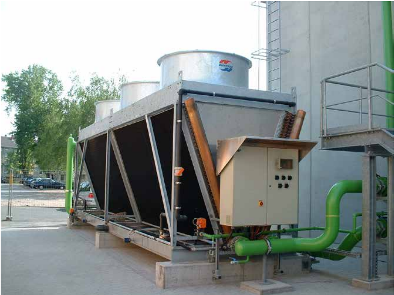
Hybrider Trockenkühler HTK 2.4/9.0 zur Prüfstandskühlung, Kühlleistung 1900 kW bei Mediumtemperaturen 35/28°C, Foto: JAEGGI Hybridtechnologie AG
