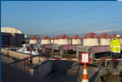
▲ Die alte Kühltechnik wurde vor der Neuinstallation abgebaut...
