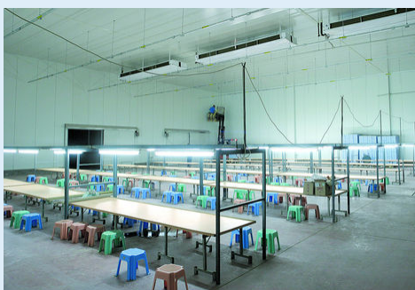
Verdampfer vom Typ S-GBK: Im Bereich Kommissionierung sichern sie die Produktqualität. Diese Geräte wurden speziell für Bearbeitungsräume entwickelt, wo sie für eine zugfreie und geräuscharme Luftführung sorgen.
