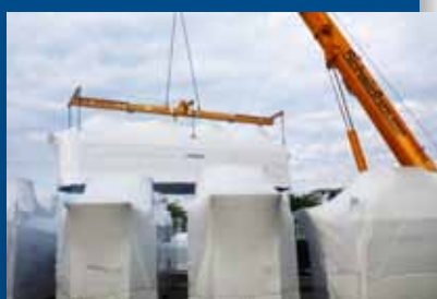
▲ Einbringung der Geräte
