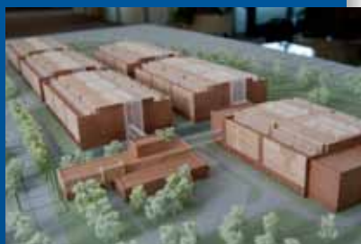
▲ Das Holzmodell des neuen Rechenzentrums verdeutlicht die Dimensionen der Anlage.
